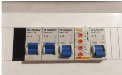
Концентратор и Песковой насос ВКЛЮЧЁНЫ.Насос смыва и Автомат ВЫКЛЮЧЕНЫ
